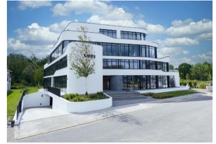
31 Neubau Gewerbe (Quelle: Firmenfoto)
